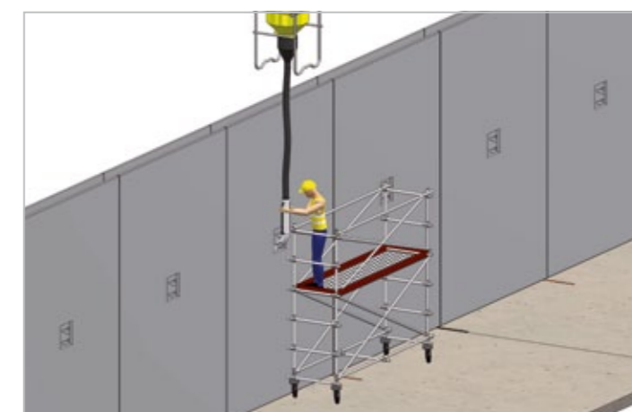
BÉTONNER PAR LES TRAPPES
